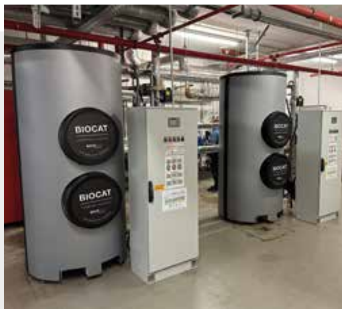
Chemiefreie Kalkschutzanlagen verändern die Trinkwasserzusammensetzung nicht. Die Kalkschutzwirksamkeit wird ohne Zugabe von Betriebsmitteln wie etwa Salz erzielt. Daraus ergibt sich ein enormes Kosteneinsparpotential (Personalressourcen, Betriebskosten, Wasserverbrauch). (Fotos/Grafiken: Watercryst)
